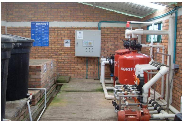
Fig 2. Estación de filtrado y fertilización con filtros de arena y malla de lavado automático.
