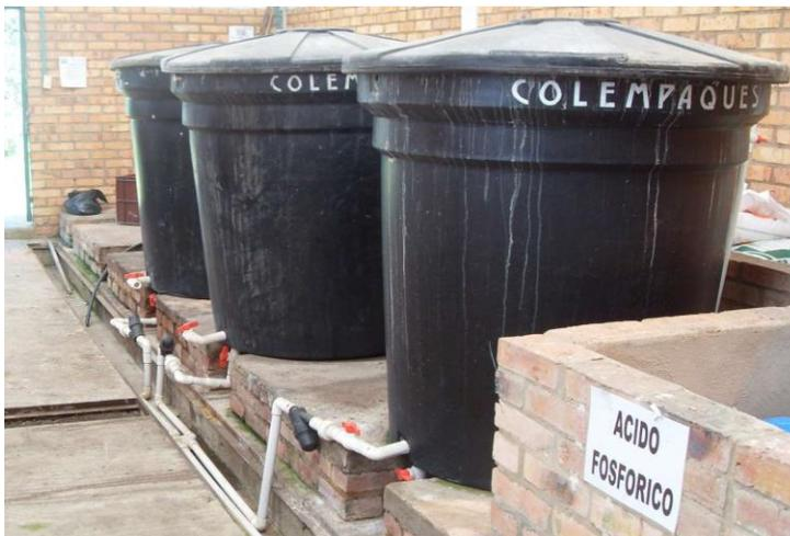
Fig 3. Tanques de fertilizante y de ácido para corregir pH.
